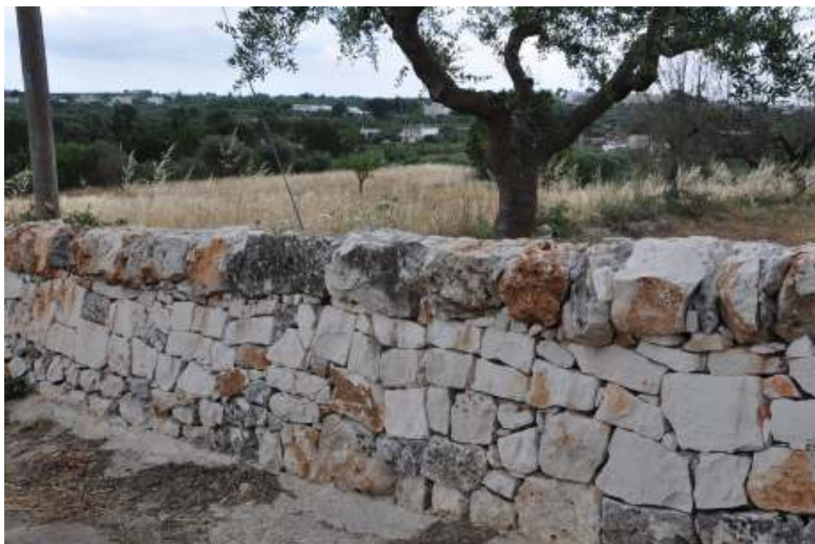
Figura 7 - Ricostruzione di parete ad "un corvello" consona alla tipologia tradizionale.
