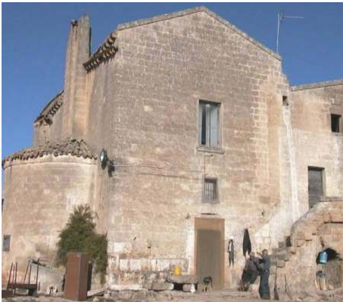
Figura 8 - Il tufo nelle strutture in elevazione.
